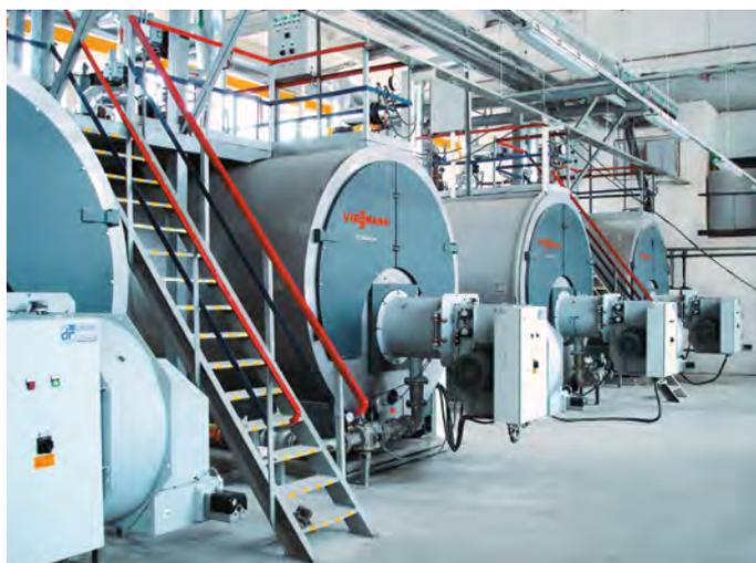
Vitomax 200-LW, chaudière d'eau chaude basse pression, puissance calorifique : 2 - 20 MW
